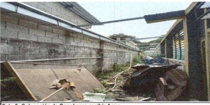
Foto 5: Colocación de Canal para recibir Agua
