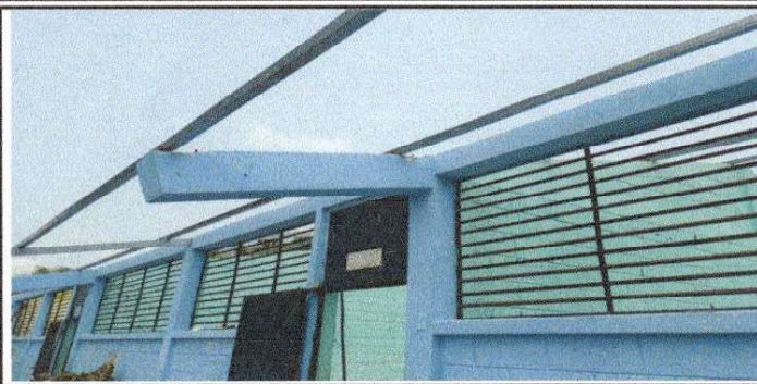
Foto 2: Sustrucion de Lámina
