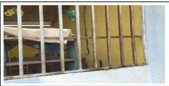
Foto 4. Sustrucion de Balcon
