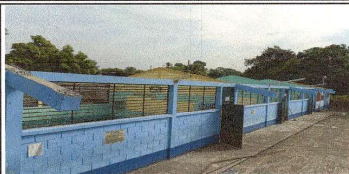
Foto1: Sustrucion de Lámina
