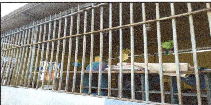
Foto 3. Sustrucion de Balcon
